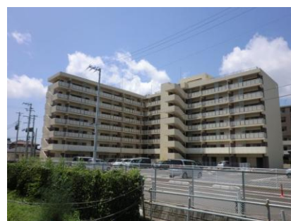
▲石巻市は計画の約 6 割の復興公営住宅が完成しています。石巻駅近くの復興公営住宅。
