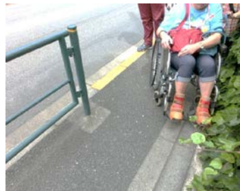
➤ 段差のある歩道、狭い幅を植物がもっと狭くしていました。
