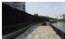
防潮堤 (隅田川)
